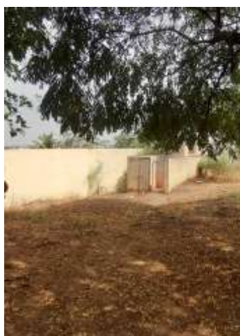
Fig 05 – New Toilet Site 02
